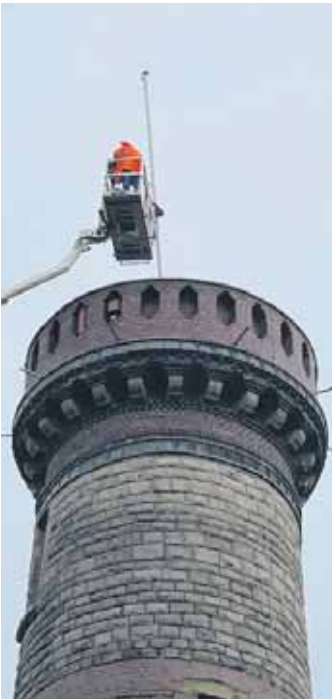
Flaggenmast auf dem Weg in die Hülse. (Foto: BVV)
