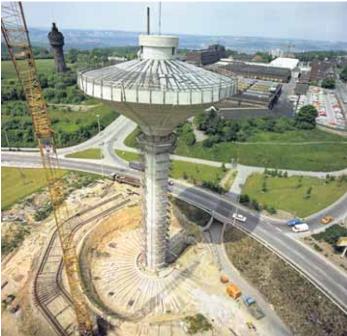
Der Wasserturm Lichtscheid im Bau. Im Hintergrund ist sein Vorgänger zu sehen. (Foto: WSW)
