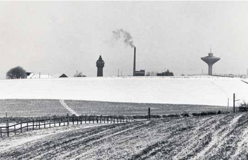
Zwei Jahre lang waren der alte und der neue Wasserturm von der Ronsdorfer Höhe aus zu sehen. Im Jahr 1977 wurde der alte Wasserturm gesprengt. (Foto: db)
