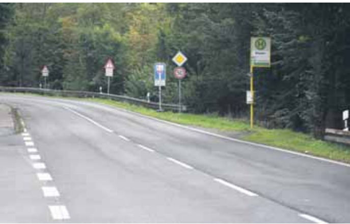
Hier, an der Verbindung Ronsdorfer Straße und Birgden III soll eine Querungshilfe errichtet werden. Außerdem soll die Bushaltestelle ausgebaut werden. (Foto: SK)
