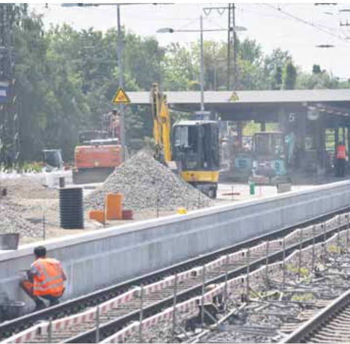
„Nacharbeiten?“ – In Wuppertal-Vohwinkel sieht die komplette Neugestaltung der S-Bahn-Bahnsteige nach ein wenig mehr als „Nacharbeiten“ aus. (Foto: PK)
