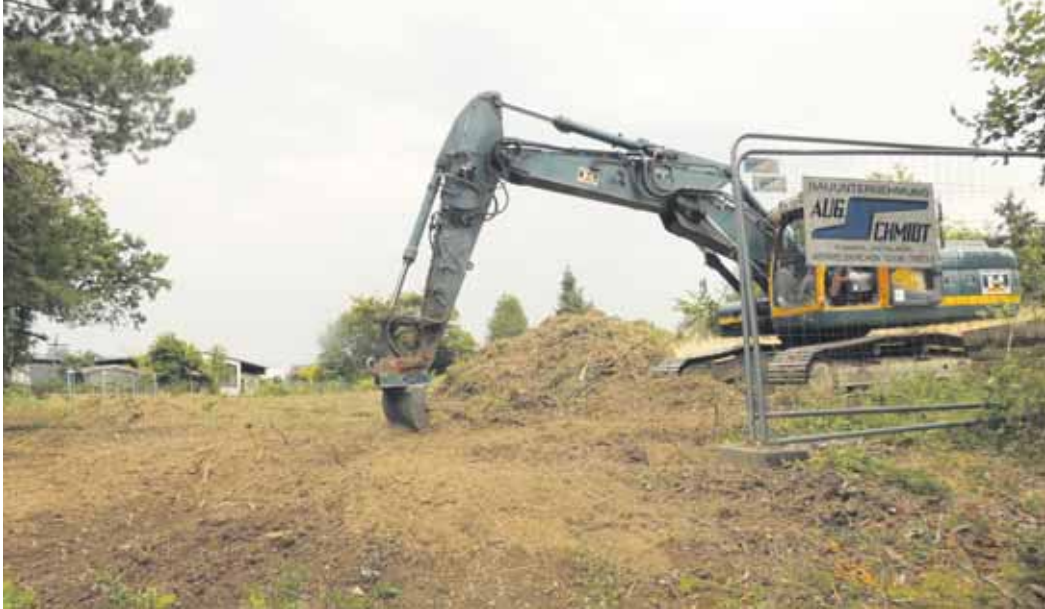
Zur Vorbereitung für die anstehenden Erdarbeiten wird zur Zeit das Areal an der Grenze von Ronsdorf zu Lüttringhauser Gebiet (Rädchen/Langenhaus) fachmännisch entwurzelt, gesäubert und planiert.
