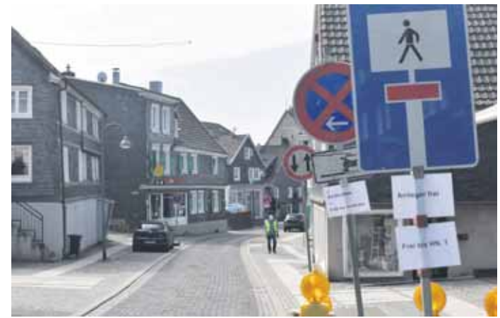
Ein kleiner Schilderwald informiert über die Baustelle an der unteren Gertenbachstraße. (Foto: PK)
