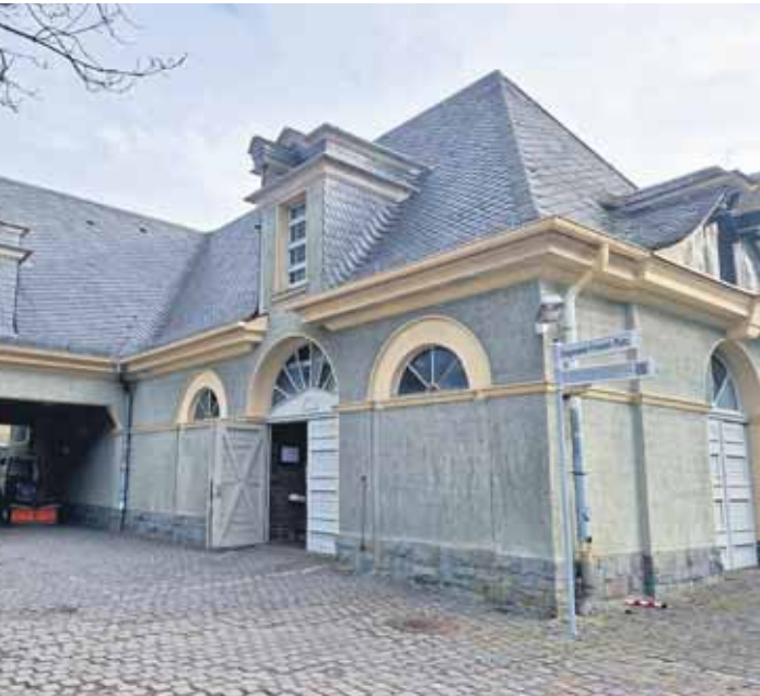
Die Gedenk- und Bildungsstätte „Pferdestall“ in Remscheid ist über eine Hinterhofterasse am Gebäudekomplex Martin-Luther-Straße 70-76 zugänglich. (Fotos: LMP)
