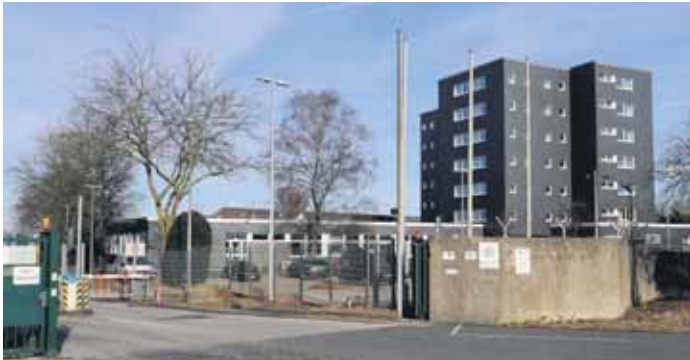
Die letzten Neubebauungen auf dem Gelände der Bereitschaftspolizei erfolgten in den 1970er Jahren. (Foto: LMP)
