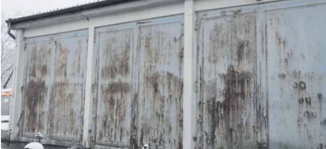
Hinter solchen Toren sollen teure Einsatzfahrzeuge gesichert sein. (Foto: db)
